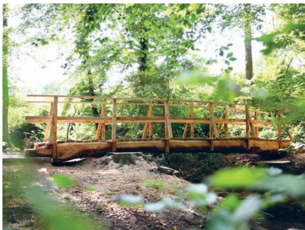
REMPLACEMENT D'UN PONT DANS UNE FORÊT DE LA COMMUNE DE GROLLEY (FR), 2020. © NICOLE MATSCHOSS
