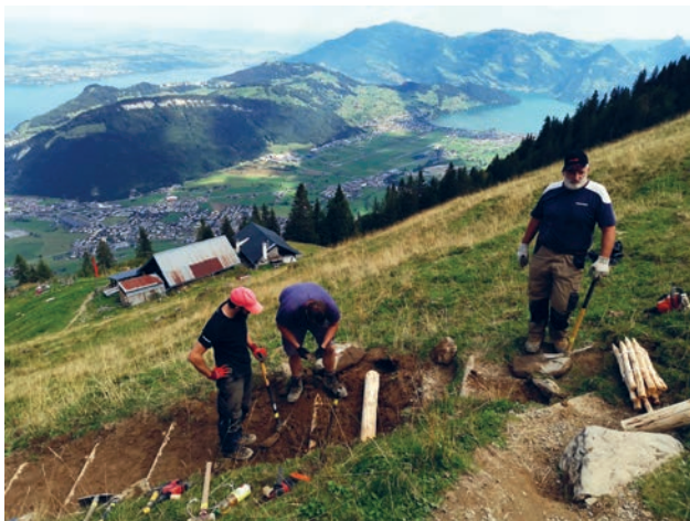
REMISE EN ÉTAT DU CHEMIN DE LA RINDERALP, STANS (NW), 2021 © STEFAN LUSSI
